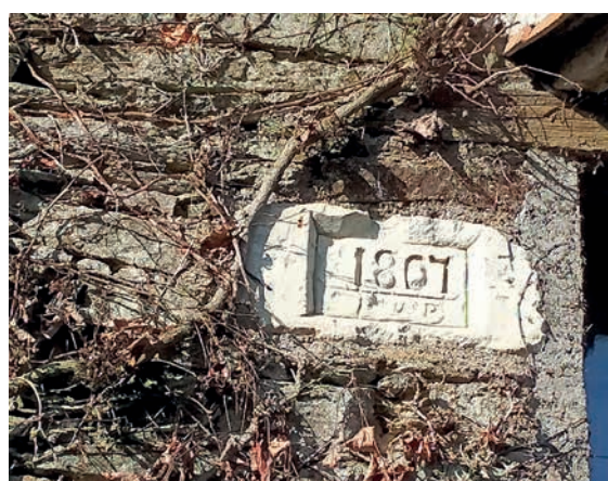
Joseph Piou construit ce bâtiment en 1807. Le rez-de-chaussée sert de pressoir et de magasin, l'étage de logement.
